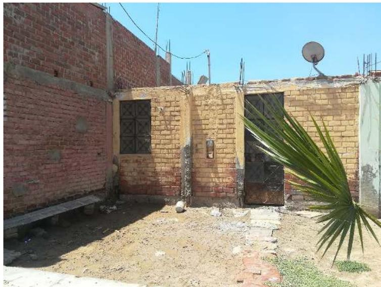
*Ilustracion 78 . ES UNA VIVIENDA DE ALBAÑILERIA CONFINADA DONDE LA SECCION DE LA COLUMNA SE HA REDUCIDO.*
