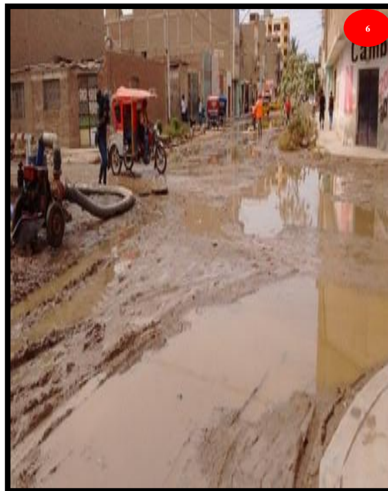
Fig.20.06. Colapso de redes de alcantarillado, Calle Conquista y Roma, Upis primero de mayo-Sector I Fuente: Propia
