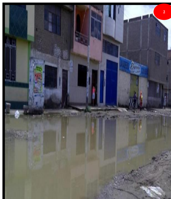
Fig.20.02. Colapso de redes de alcantarillado, Calle Abancay y Portales, Upis primero de mayo-Sector I Fuente: Propia
