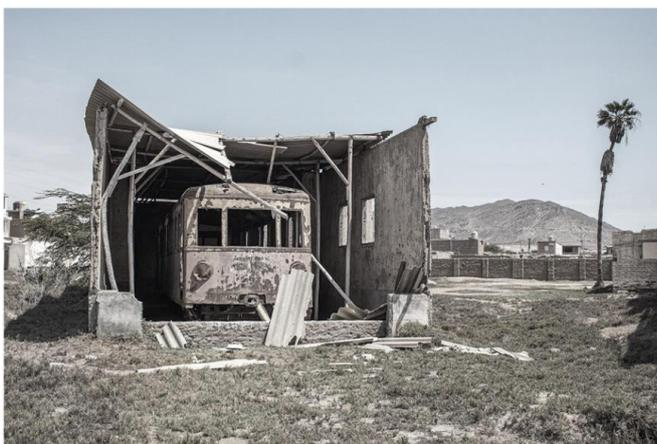
*Figura 20 Estado actual de los depósitos de locomotoras, estructuras en riesgo de colapso. Fuente: Elaboración propia.*
