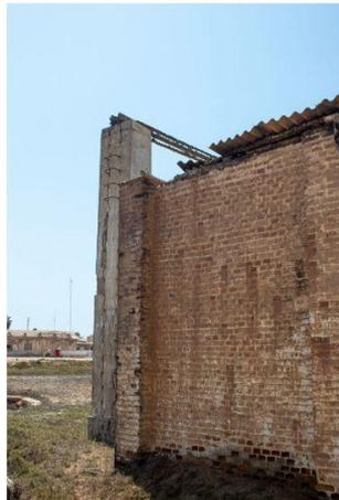
PRESENCIA DE EROSIÓN EN LOS MUROS DE LADRILLO, ASI COMO FISURAS, PERDIDA DE PIEZAS EN LA ESTRUCTURA DE LA COBERTURA.
