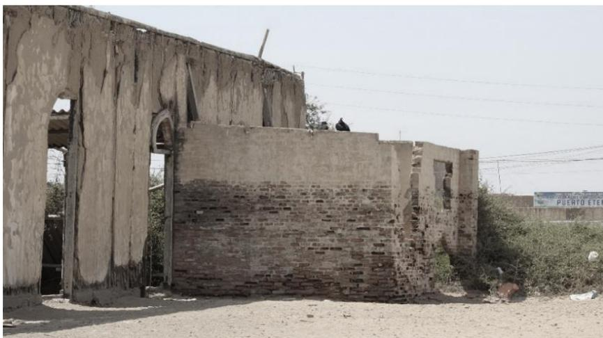
*Figura 13 Estado actual de las edificaciones de la estación, vista del material que compone los muros. Fuente: Elaboración propia.*
