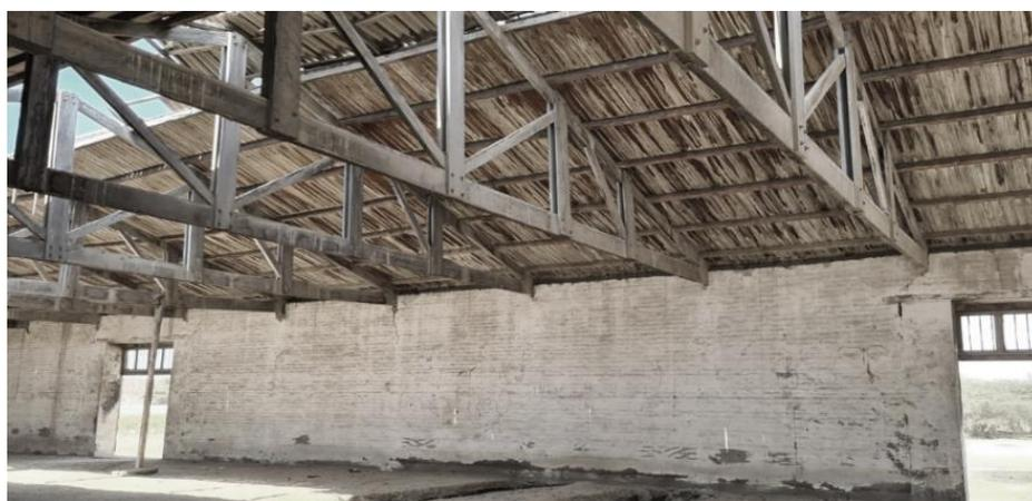
*Figura 19 Interior del almacén principal, vista del estado actual de muros, tijerales y cubierta. Fuente: Elaboración propia.*
