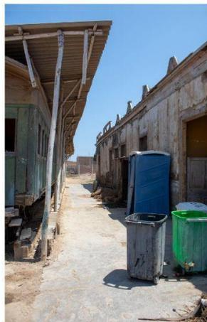
PERDIDA DEL REVESTIMIENTO DE LOS MUROS DEBIDO A LA EROSIÓN, PRESENCIA DE DESMONTES Y LA GRAN CANTIDAD DE BASURA ABANDONADA EN EL LUGAR.
