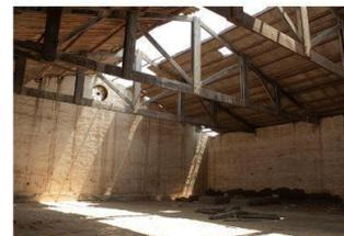
ESTADO ACTUAL DEL ALMACE PRINCIPAL, DIFERENTE TIPO DE COBERTURA, A LA DERECHA, LAMINAS DE ETERNIT Y A LA IZQUIERDA LA CUBIERTA ORIGINAL DE TABLONES DE MADERA; DESGASTE DE TIJERALES Y DESPRENDIMIENTO DEL REVESTIMIENTO DE LOS MUROS
