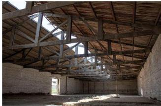
VISTA INTERIOR ALMACEN PRINCIPAL, DONDE SE PUEDE OBSERVAR EL ESTADO DE LOS TIJERALES DE MADERA, LOS MUROS Y LOS PISOS
