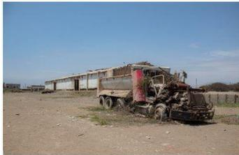
EXTERIOR DEL ALMACEN PRINCIPAL, SE PUEDE OBSERVAR EL ESTADO DE LOS MUROS Y LA ANTIGUA PLATAFORMA, ASI COMO DESMONTES Y MAQUINARIA QUE HA SIDO ABANDONADA EN LA ESTACIÓN
