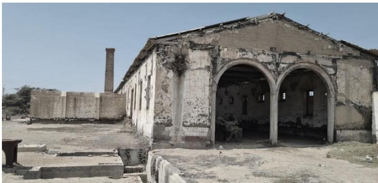
*Figura 22 Fachada principal de la maestranza por el cual ingresaban las locomotoras, estado actual de los muros y espacios exteriores inmediatos. Fuente: Elaboración propia.*
