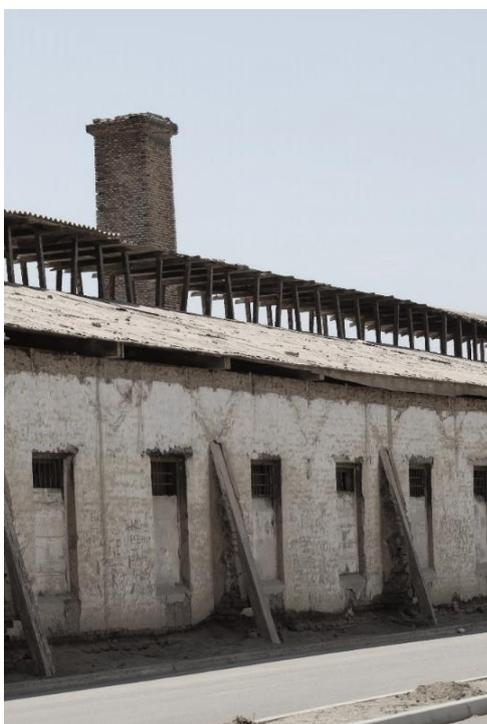
*Figura 23 Vista lateral de la maestranza, estructura de soporte que refuerza el muro. Fuente: Elaboración propia.*
