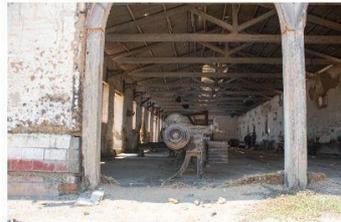
DESGASTE DE MUROS EXTERIORES Y DE LAS MAQUINARIAS, DESPINDIMIENTO DE LOS REVESTIMIENTOS DEBIDO A LA EROSIÓN, ASI COMO LA PRESENCIA DE DESMONTES Y MALEZA
