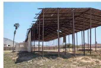
PERDIDA DE PIEZAS, DE ESTE EDIFICIO QUEDA SOLO UN MURO LATERAL EN PIE, ESTE PRESENTA DESPINDIMIENTO DE REVESTIMIENTO POR EROSIÓN, LA NUEVA COBERTURA SE ENCUENTRA TAMBIEN EN MAL ESTADO.
