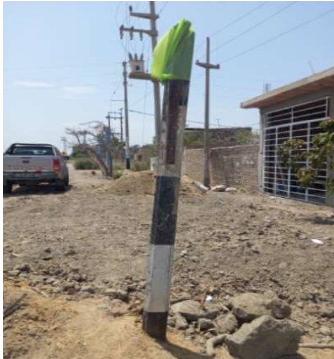
FIGURA N° 68: Señalización en mal estado Km 12+000 El Rinconazo
