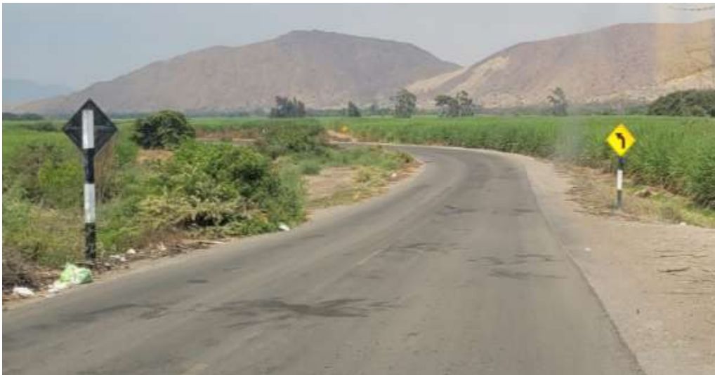
FIGURA N° 70: Señalización existente de la vía
