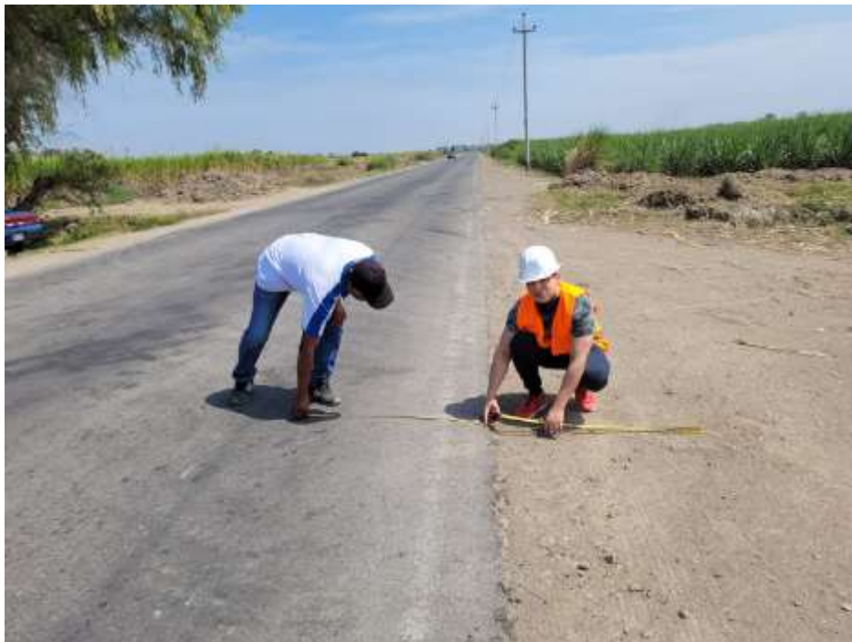
FIGURA N° 76: Medición de ancho de calzada de la vía
