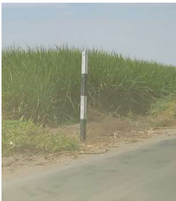
FIGURA N° 12: Soporte sin señalización vertical
