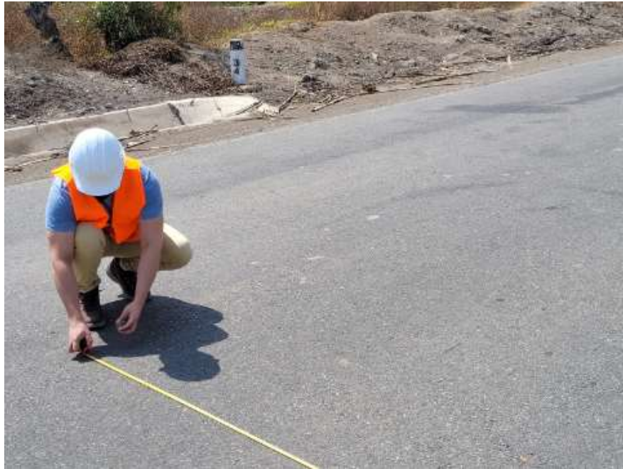
FIGURA N° 75: Medición de ancho de calzada de la vía
