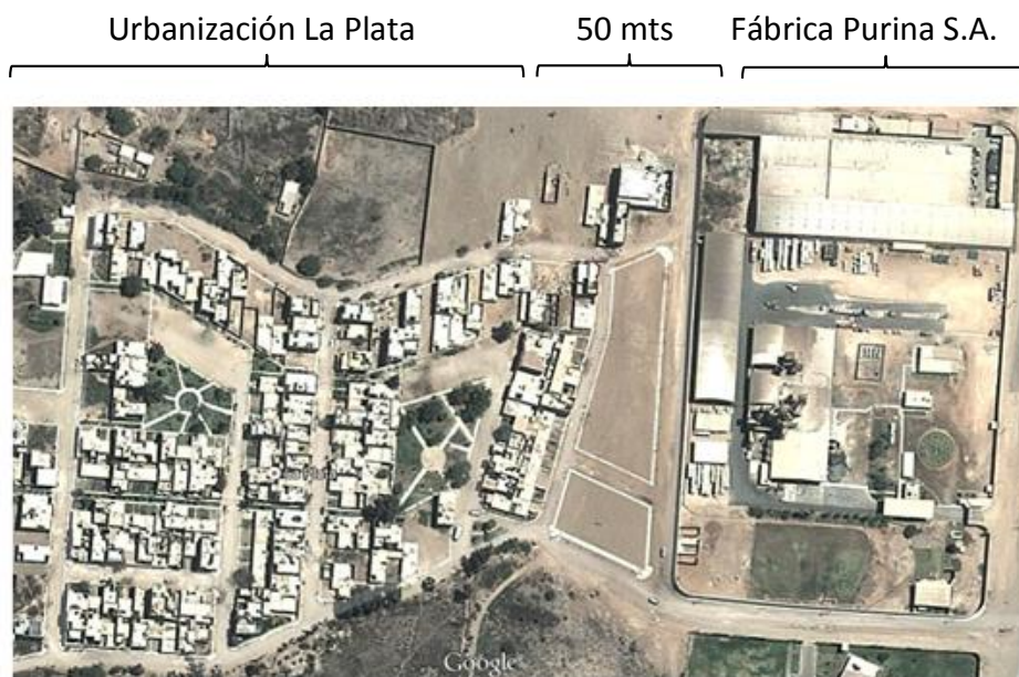
Figura N° 09: Foto aérea con localización de la urbanización La Plata y fábrica Purina S.A.
