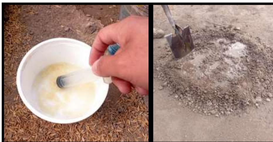
Fig. 57 De izquierda a derecha: Preparación de la cantidad de Consolid 444 apropiada ( 1.00 \text{ lt/m}^3 ). Aplicación del aditivo Consolid 444 a la cantidad de tierra designada
