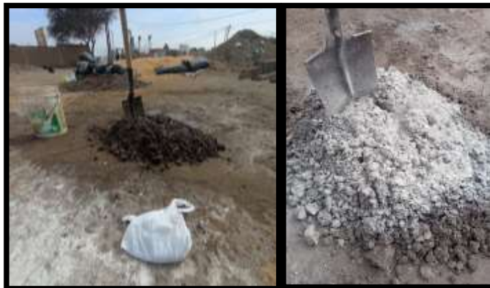
Fig. 58 De izquierda a derecha: Mezcla de barro preparada con aditivo Consolid 444 y cantidad de aditivo Solidry previamente pesada y separada en una bolsa. Aplicación de la cantidad designada de aditivo
