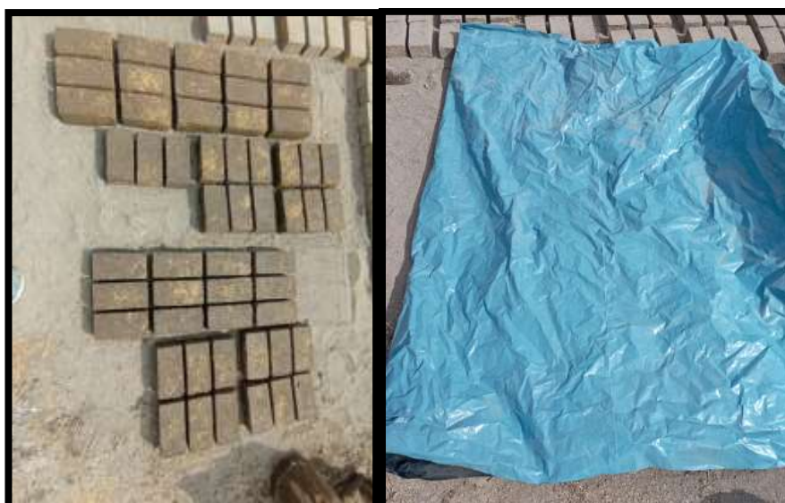
Fig. 68 De izquierda a derecha: Elaboración de adobes para cada dosificación propuesta de óxido de calcio. Cubierta de adobes elaborados para protección contra el sol y la lluvia por el periodo de 28 días
