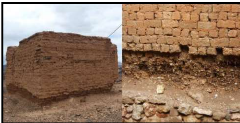
Fig. 3 Pérdida de sección de un muro de bloques de adobe por aumento de la humedad capilar: A la derecha: Vivienda en Fuerteventura, Las Palmas (España). A la izquierda: Muro en Poza de Sal, Burgos (España).
