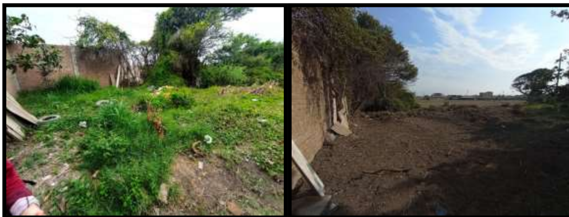
Fig. 22 De izquierda a derecha: Estado del terreno previa intervención. Eliminación de vegetación, aplanado y, limpieza manual del terreno
