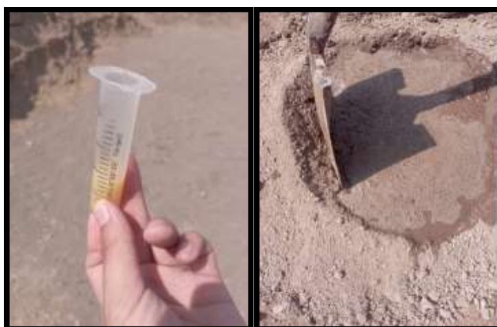
Fig. 65 De izquierda a derecha: Cantidad óptima del aditivo líquido Consolid 444. Aplicación del aditivo Consolid 444 diluido en tres partes de agua
