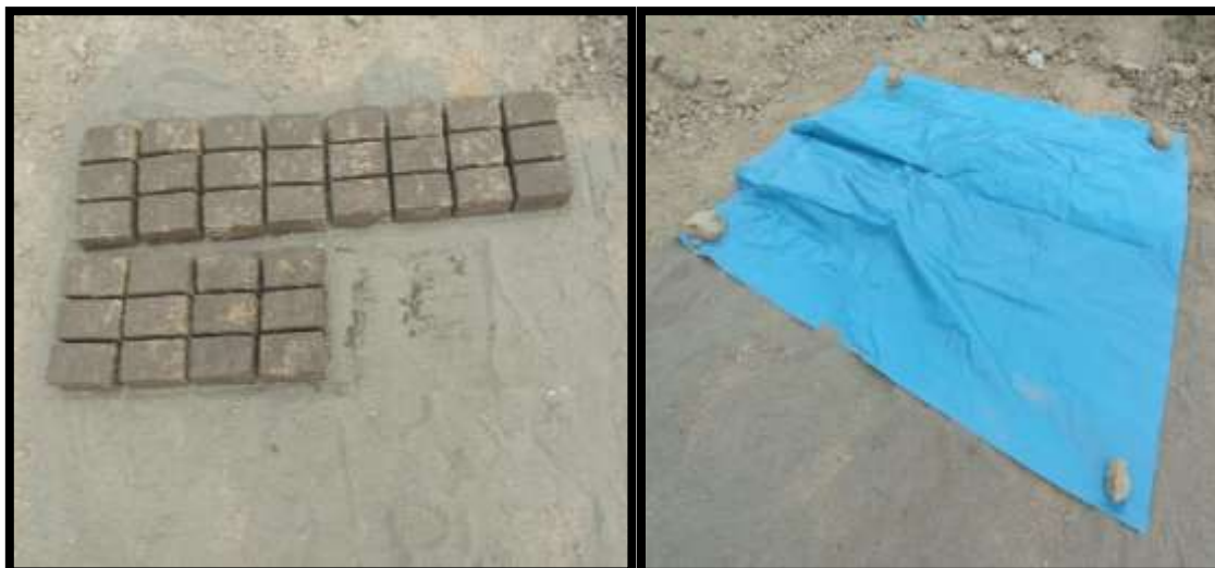
Fig. 50 De izquierda a derecha: Desmoldado de adobes convencionales requeridos. Protección de los adobes con cubierta de plástico por 28 días de secado
