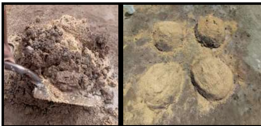
Fig. 59 De izquierda a derecha: Mezclado del barro con Solidry e incorporación de paja. Preparación de morros de mezcla para adobe en las 4 dosificaciones de aditivo Solidry planteadas
