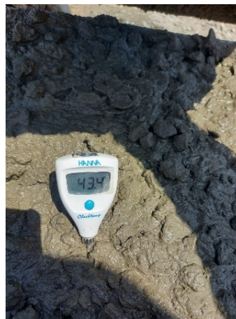
Ilustración 11: Temperatura del concreto fresco, en colocación
