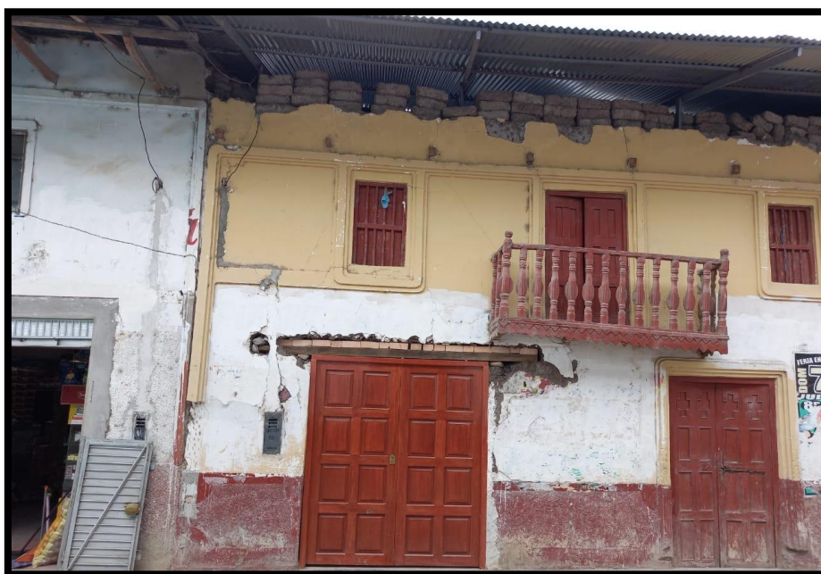
Imagen 35: Vivienda de adobe por el exterior en estado moderado en el Distrito de Chalamarca. Fuente: Propia
