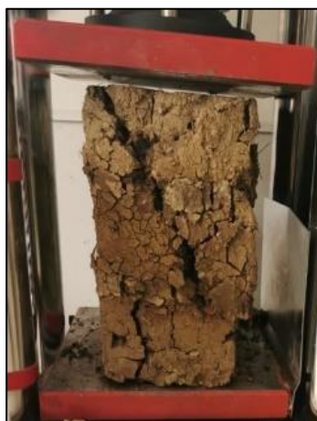
Imagen 26: Adobe tradicional, sometido al ensayo de murete a la compresión. Fuente: Propia.
