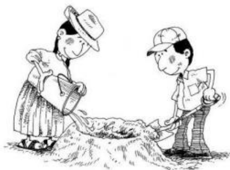
Ilustración 3: Preparación del barro para la elaboración de adobes. Fuente: Ministerio de Vivienda, Construcción y Saneamiento. Manual de Construcción con Adobe.
