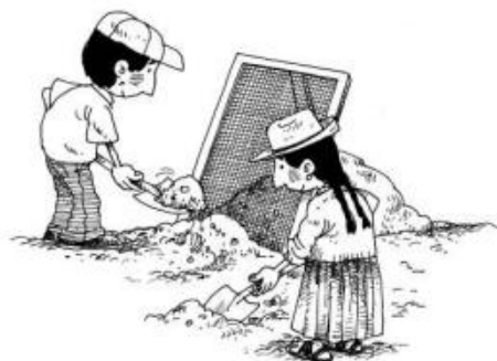
Ilustración 02: Preparación del barro para la elaboración de adobes. Fuente: Ministerio de Vivienda, Construcción y Saneamiento. Manual de Construcción con Adobe.
