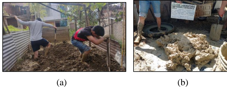
Imagen 4: Fabricación de Adobes: (a) Mezclado homogéneo (b) Masa trabajable para adobes con incorporación de paja. Fuente: Propia.
