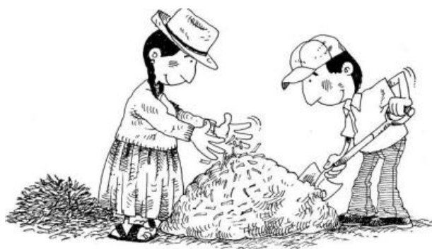
Ilustración 4: Preparación de la paja. Fuente: Ministerio de Vivienda, Construcción y Saneamiento. Manual de Construcción con Adobe.
