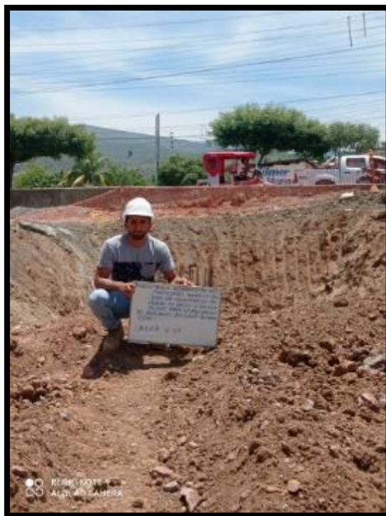
Ilustración 34: Para la CALICATA 04, se realizó en el sector Esperanza Baja de la ciudad de Bagua Grande.
