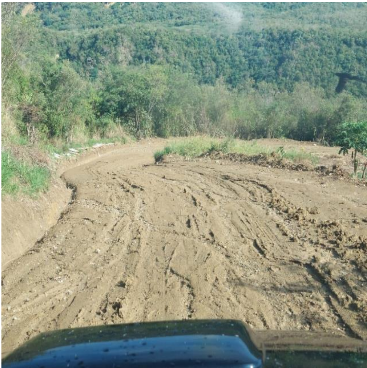
Ilustración 1: Evidencias de la realidad problemática en la provincia de Utcubamba, caserío de la ciudad de Bagua Grande, suelos en índice de plasticidad elevada, que en épocas de lluvia se convierten en zonas intransitables.
