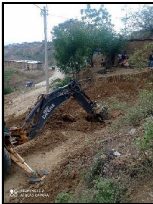
Ilustración 28: MAQUINARIA REALIZANDO EXCAVACIÓN CALICATA 01
