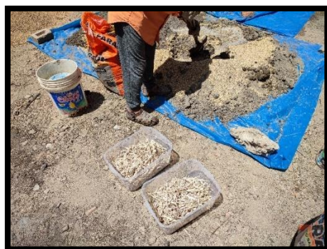
Figura 39. Añadiendo las fibras vegetales al dormido
