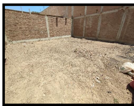
Figura 29. “Casuarinas” después del trabajo de desbroce y limpieza de terreno.
