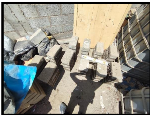
Figura 153. Pilas de adobe finalizadas
