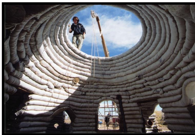
Figura 8. Construcción de una vivienda empleando superadobe
