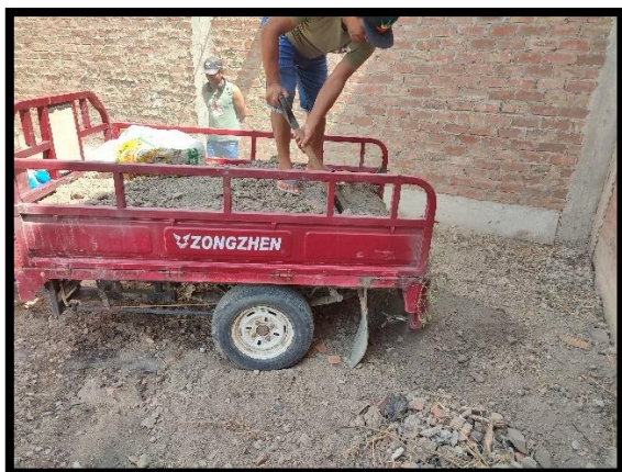
Figura 34. Suministro de material “suelo” en motocarga
