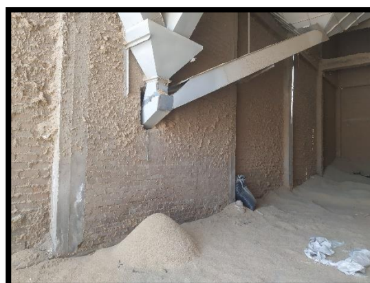
Figura 61. Tubería donde cae la cáscara de arroz después del proceso de molienda
