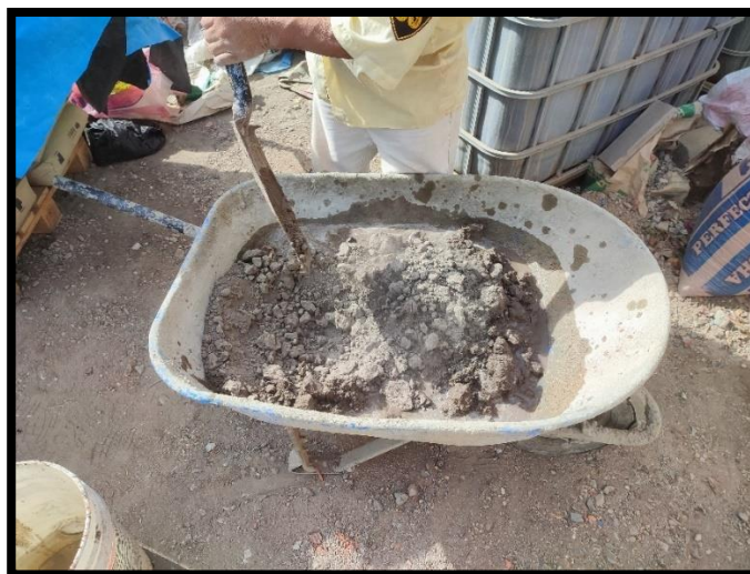
Figura 103. Preparación del mortero de barro
