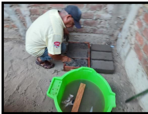
Figura 42. Moldeando el adobe y enrasando con una regla de madera
