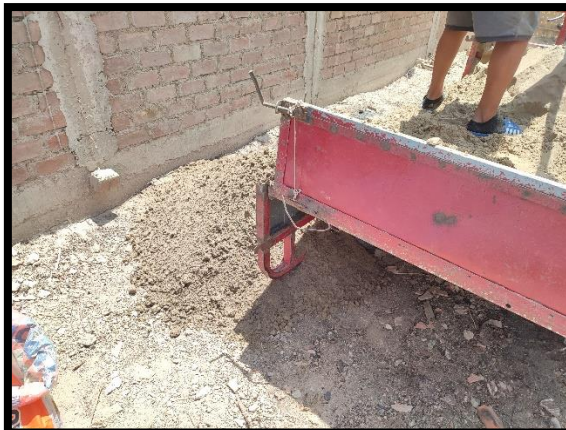
Figura 35. Suministro de material “arena fina” en motocarga
