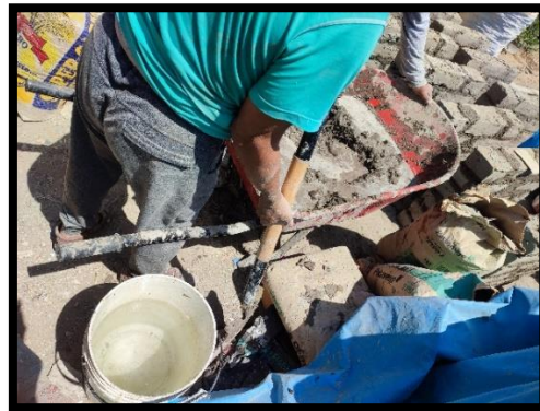
Figura 152. Preparación del mortero de barro para pegar las pilas
