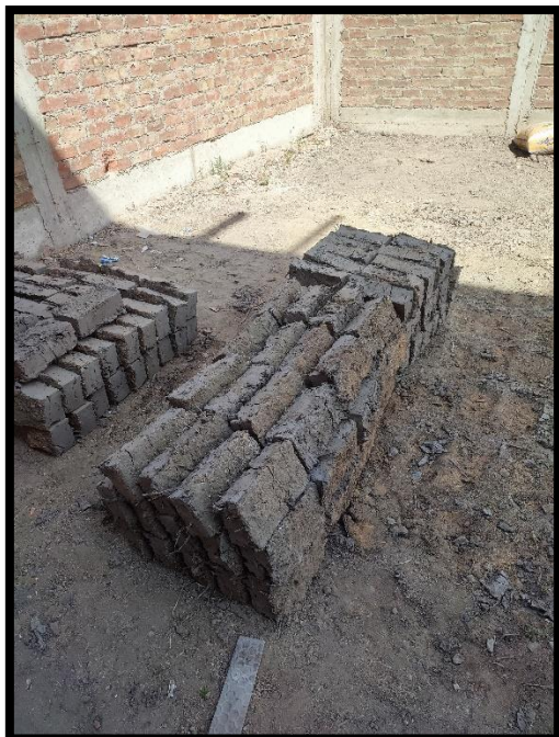
Figura 45. Apilando el adobe en 3 niveles de canto
