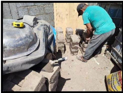
Figura 151. Construcción de pilas de 4 hiladas
