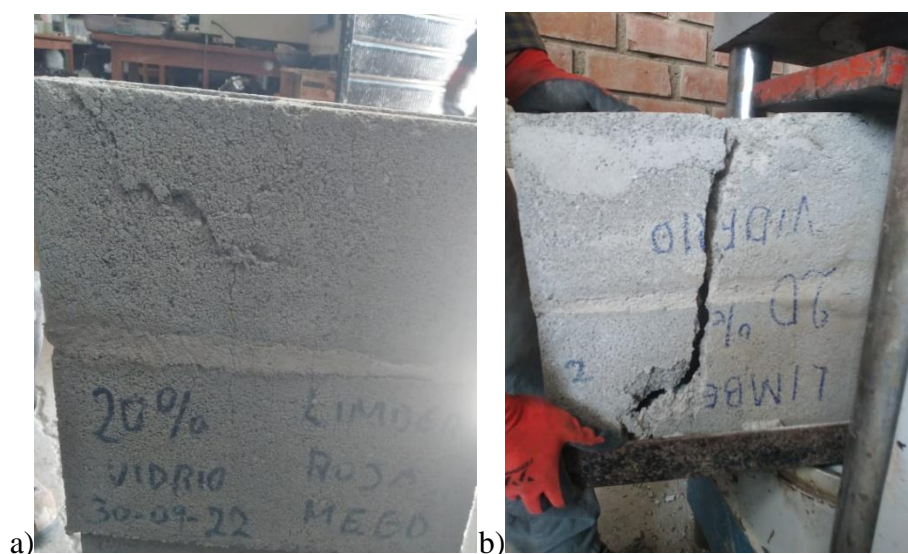
Figura N°53. Falla de pilas con 20 % de vidrio molido
