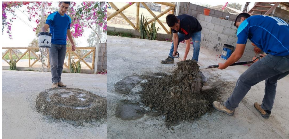
Figura N°64. Elaboración de la mezcla
