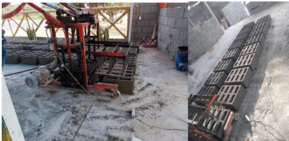
Figura N°65. Ubicación de la máquina, vaciado y vibrado de los bloques
