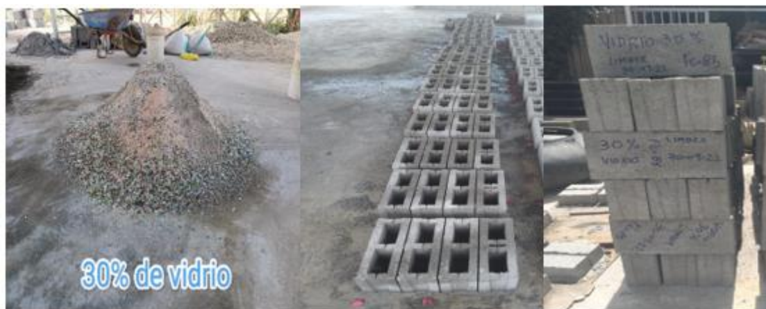
Figura N°26. Mezclado, elaboración y curado de bloques con 30 % vidrio molido
