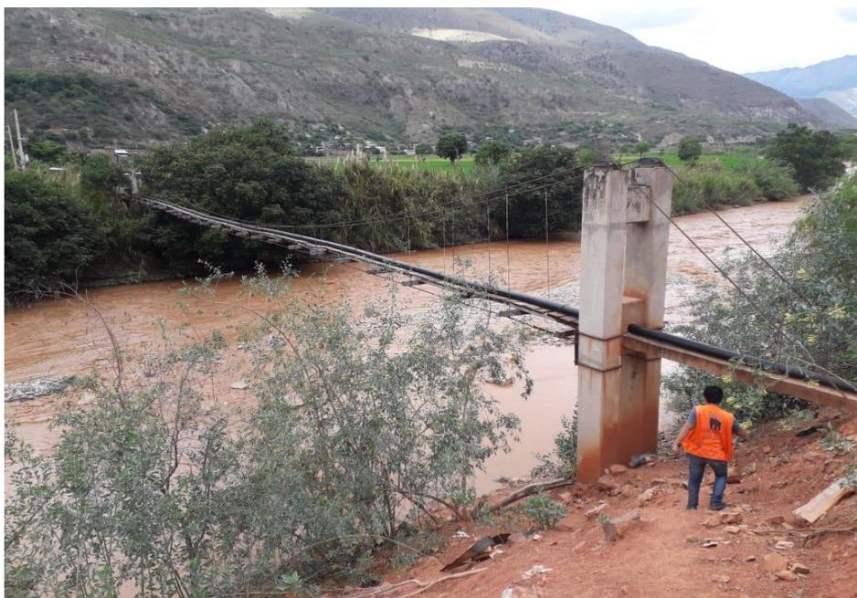
*Figura N° 130: Vista de la socavación del pilar del pase aéreo de la línea de alcantarillado desde la cámara de bombeo del desagüe hasta el caserío la Chorrera.*
