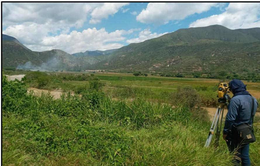
*Figura N° 18: Levantamiento topográfico de la zona en estudio.*
