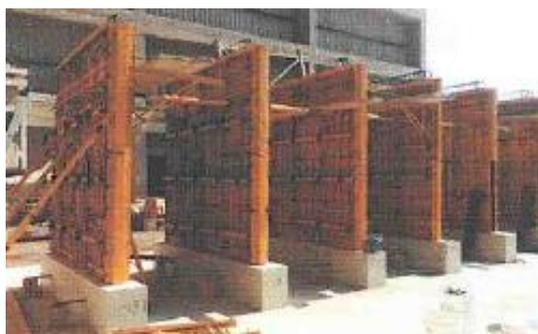
*Ilustración 27: Encofrado de los nueve muros*
