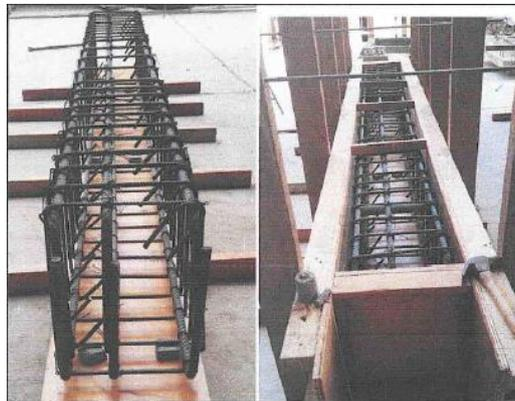
*Ilustración 20: Encofrado de las vigas de cimentación*
