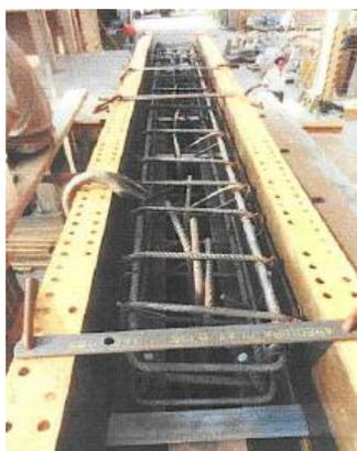
*Ilustración 28: Encofrado de viga solera*
