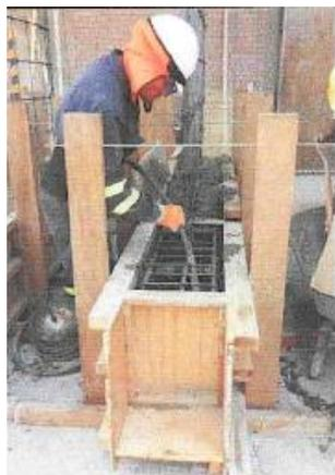
*Ilustración 23: Compactación del concreto*
