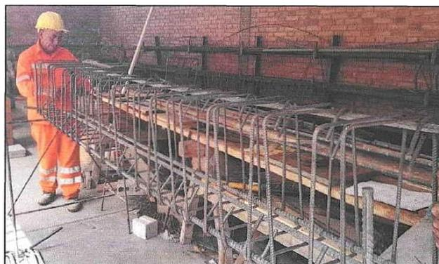
*Ilustración 18: Habilitación del acero de refuerzo de vigas de cimentación*
