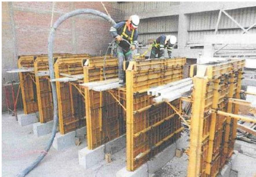
*Ilustración 30: Vaciado de los muros y vigas soleras de los nueve muros*
