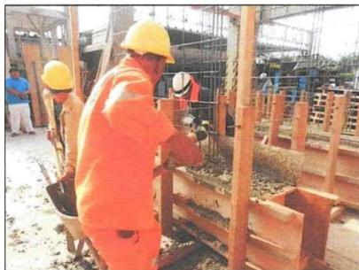
*Ilustración 22: Vaciado de concreto de resistencia  $f'c = 210$  kg/cm<sup>2</sup> en las vigas de cimentación.*
