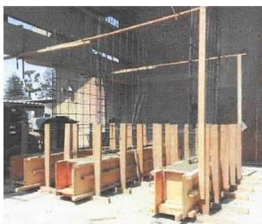
*Ilustración 24: Vigas de cimentación al finalizar el vaciado*
