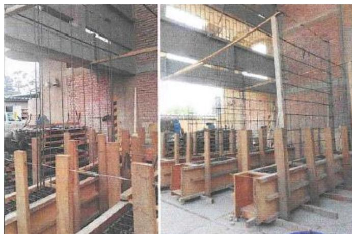
*Ilustración 21: Encofrado de vigas de cimentación y armado de acero vertical del muro de ductilidad limitada.*
