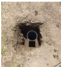
Figura 7: Colocación de tubería de 4"
