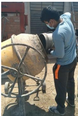
Figura 50: Utilización del trompo para el mezclado de los áridos naturales, reciclados más aditivo y agua para fabricación del concreto poroso.
