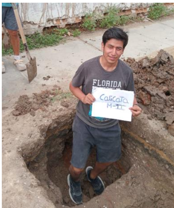
Foto 4.2: Calicata 2- Calle José Baquijano Cuadra 5
