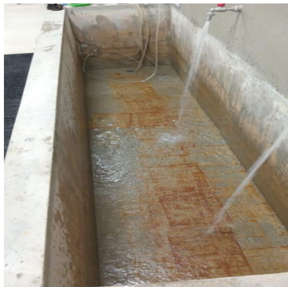
Foto 85: Llenado del lavadero con agua
