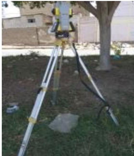
Foto 3.5: Estación total ubicado a un costado del canal
