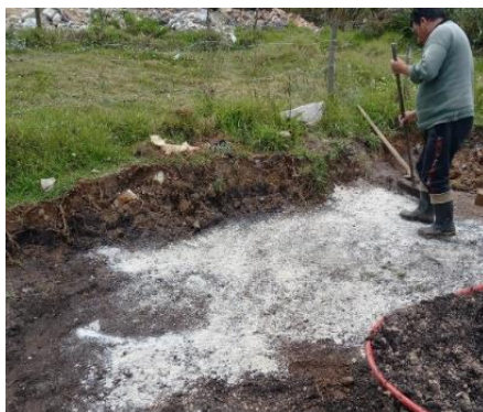
Figura 41. Preparación del terreno
