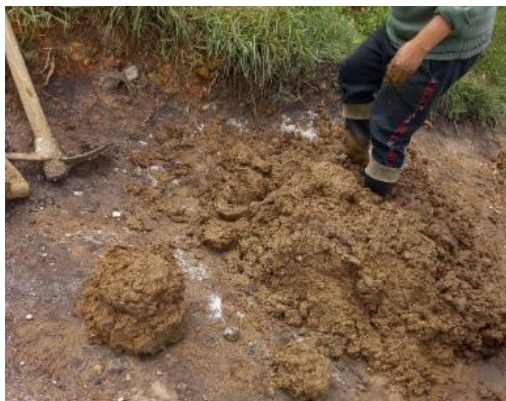
Figura 40. Preparación de la mezcla
