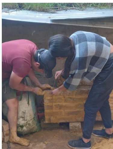
Figura 57. Fabricación de muretes.
