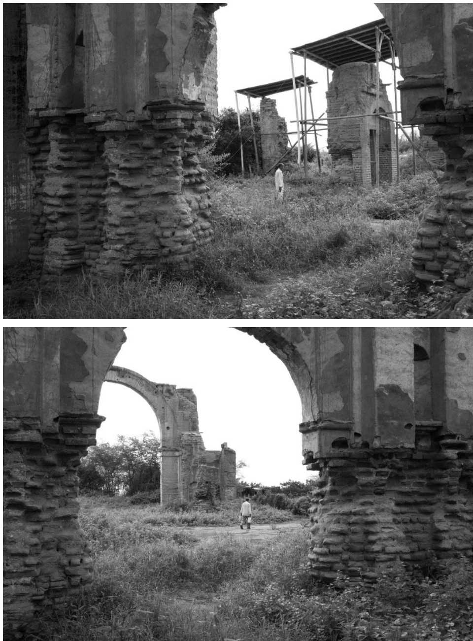
Figura No. 39 - 40: “Caminando entre gigantes petrificados”, en la fotografía podemos ver a una persona de avanzada edad caminando entre las gigantescas ruinas, regalándonos una inesperada noción de la escala real del elemento construido y su imponente presencia. Una situación cotidiana para el poblador de Zaña que convive y es vecino de estos entes resilientes. (revisar anexo 13). Fuente propia (2023).
