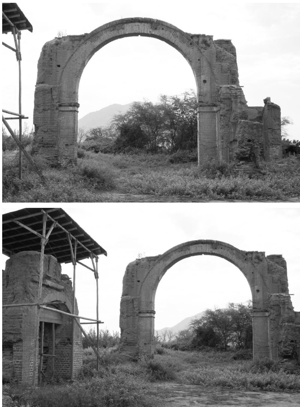
Figura No. 44 - 45: Vista del arco mayor, que resiste casi intacto y del arco de medio punto que serían los restos de un acceso lateral. Encontramos diferentes grados de lesiones y trabajos de conservación pasados. Fuente propia (2023).
