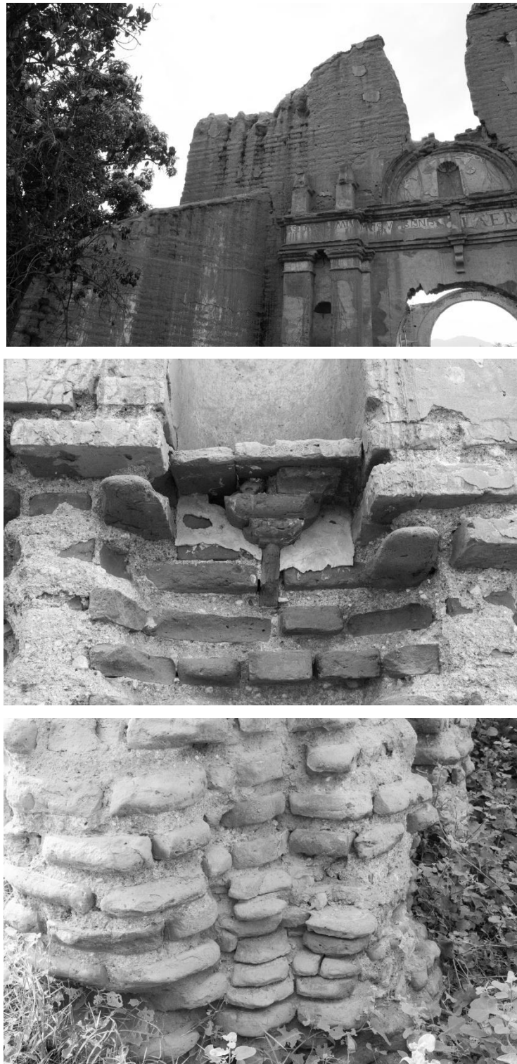
Figura No. 41 – 42 - 43: Se muestra el detalle de la pérdida y desgaste en la parte superior del pórtico además de elementos constructivos al descubierto por acción del tiempo y la erosión. Además, podemos hacer un registro de los diferentes tipos de piezas de albañilería concebidas para formar las molduras y demás formas ornamentadas que podemos encontrar en el todo el pórtico. ( revisar anexo 14, 15, 16 ). Fuente propia (2023).
