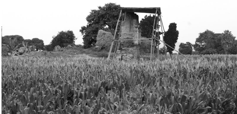
Figura No. 33: A su alrededor encontramos las ruinas de la Iglesia Matriz de Zaña, la cual acompaña permanentemente a la San Francisco y que de igual manera se encuentra rodeada por terrenos de cultivo que comprometen las estructuras que quedan en pie. Fuente propia (2023).
