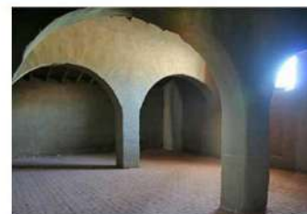
Interior de la Capilla "La Ramada" 2010
