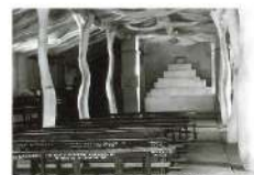
Nave de "La Ramada"
