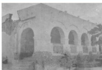
Frontera del Convento Habitacional 1988
