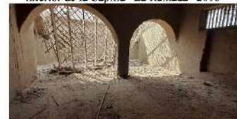
Interior de la Capilla "La Ramada" 2021
