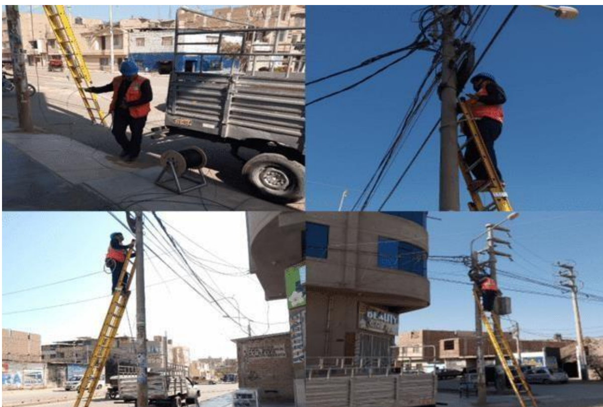
Fig. 5. Trabajadores en ejecución de tareas
