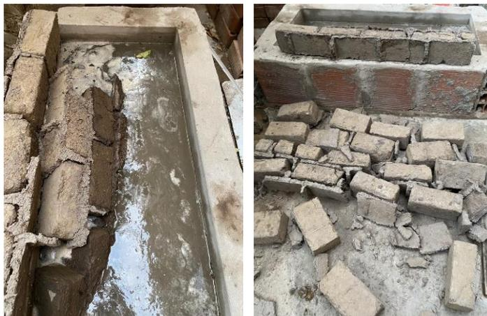
Fig 24: Caída del murete debido a la inundación
