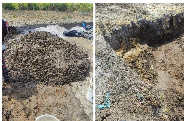
*Fig 15: Preparación del barro dormido*
