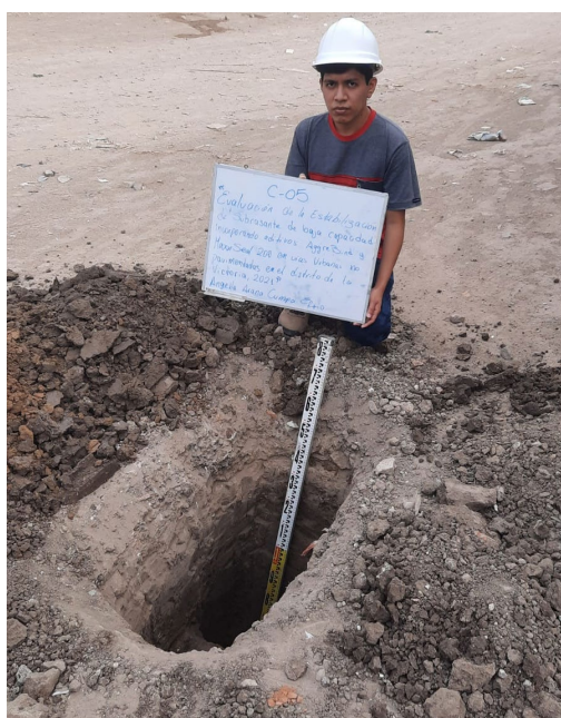
Figura 11. Reconocimiento de la Calicata 5
