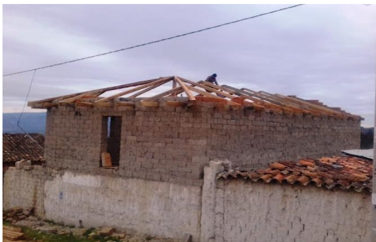
Imagen 7: Construcción de techo en madera
