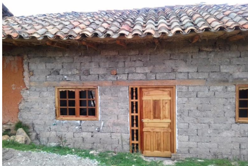
Imagen 11: Carpintería de madera en puertas y ventanas Fuente: Apuntes de arquitectura digital “Construcciones en tierra en el Centro Poblado Huancas de Chachapoyas - Arquitectura con identidad”
