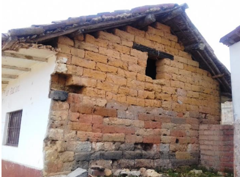
Imagen 9: Muros con ladrillos amarillos, rojizos, marrones, con ventana alta para evacuar humos y con alero para protección de las lluvias
