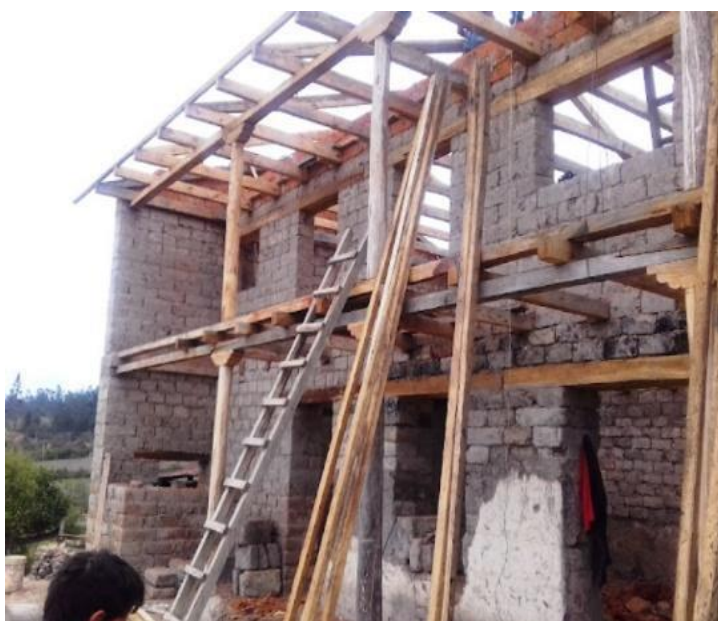
Imagen 8: Construcción con madera sobre adobe, techos, entrepiso y balcón para observar el paisaje
