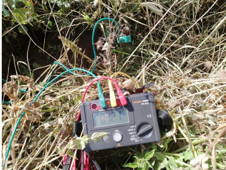
Figura 76. Medición de la resistencia de la tierra.
