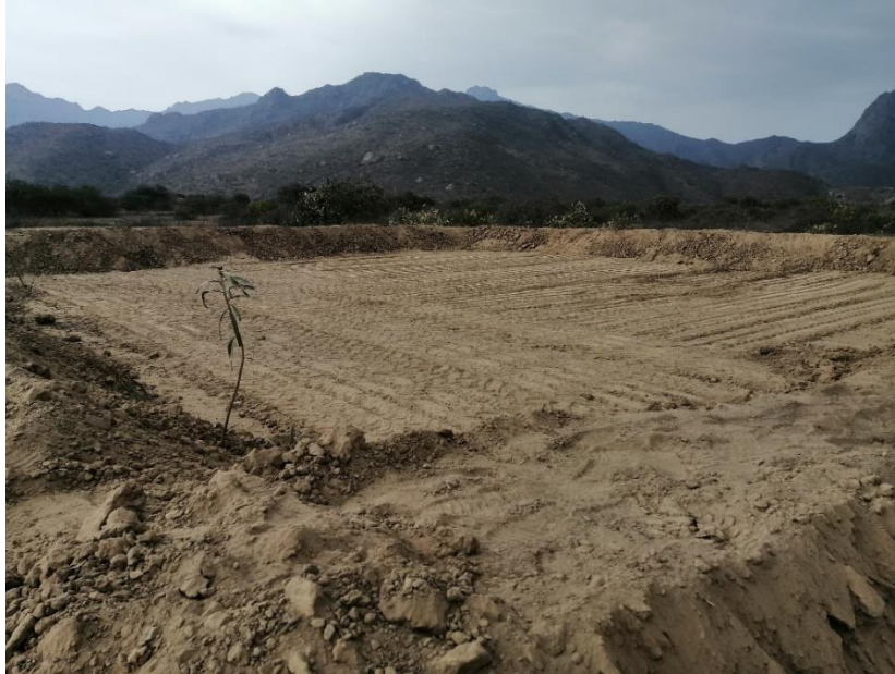
Figura 67. Construcción del reservorio de agua.
