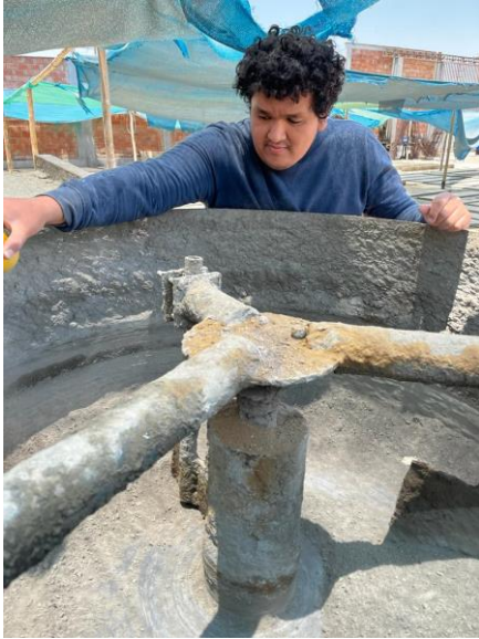
Ilustración 37: Elaboración del Concreto
