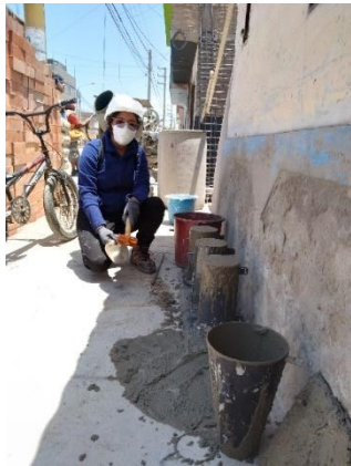
Realización de probetas y asentamiento
