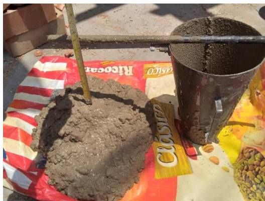
Ilustración 40: Asentamiento de la obra N°04.
