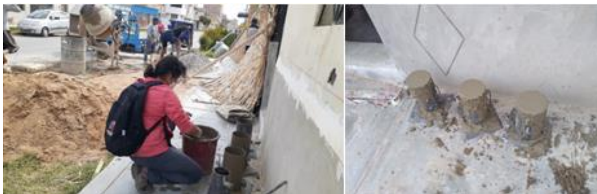
Ilustración 21: Realización de Probetas en obra
