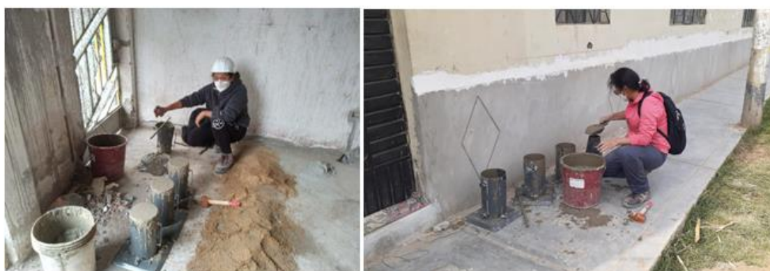
Ilustración 47: Realización de testigos.
