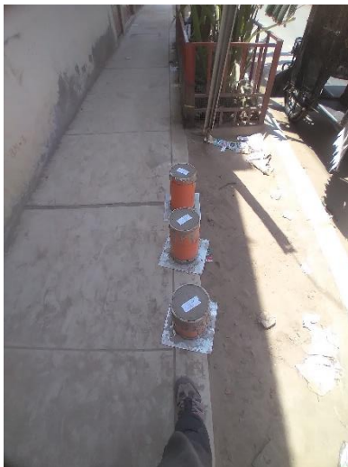
Realización de probetas y asentamiento
