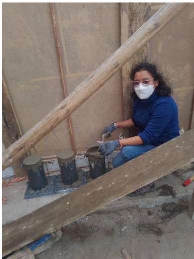
Realización de probetas y asentamiento
