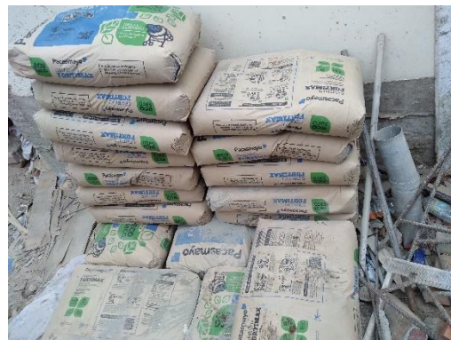
Cemento utilizado en obra
