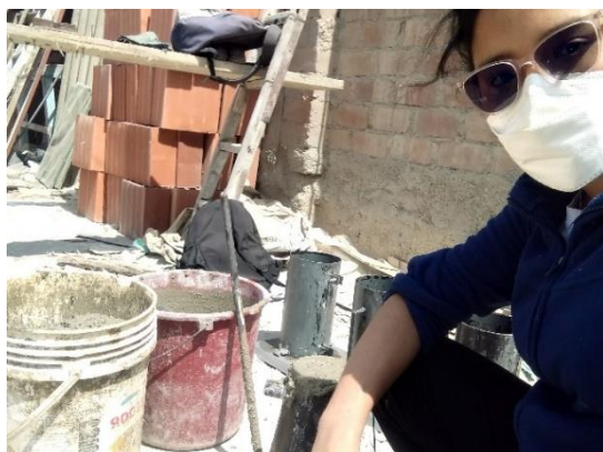
Realización de probetas y asentamiento
