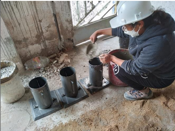
Realización de probetas y asentamiento
