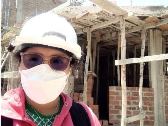
Visita de la obra
