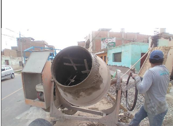
Trompo utilizado en obra
