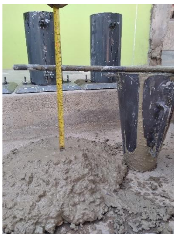
Ilustración 45: Asentamiento de la obra N°09.
