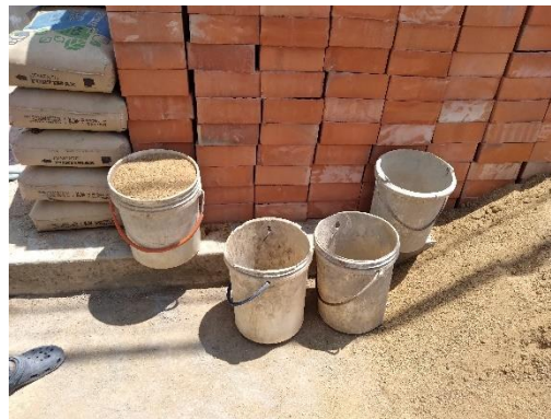
Baldes utilizados en obra
