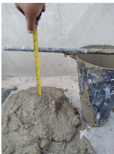
Ilustración 41: Asentamiento de la obra N°05.
