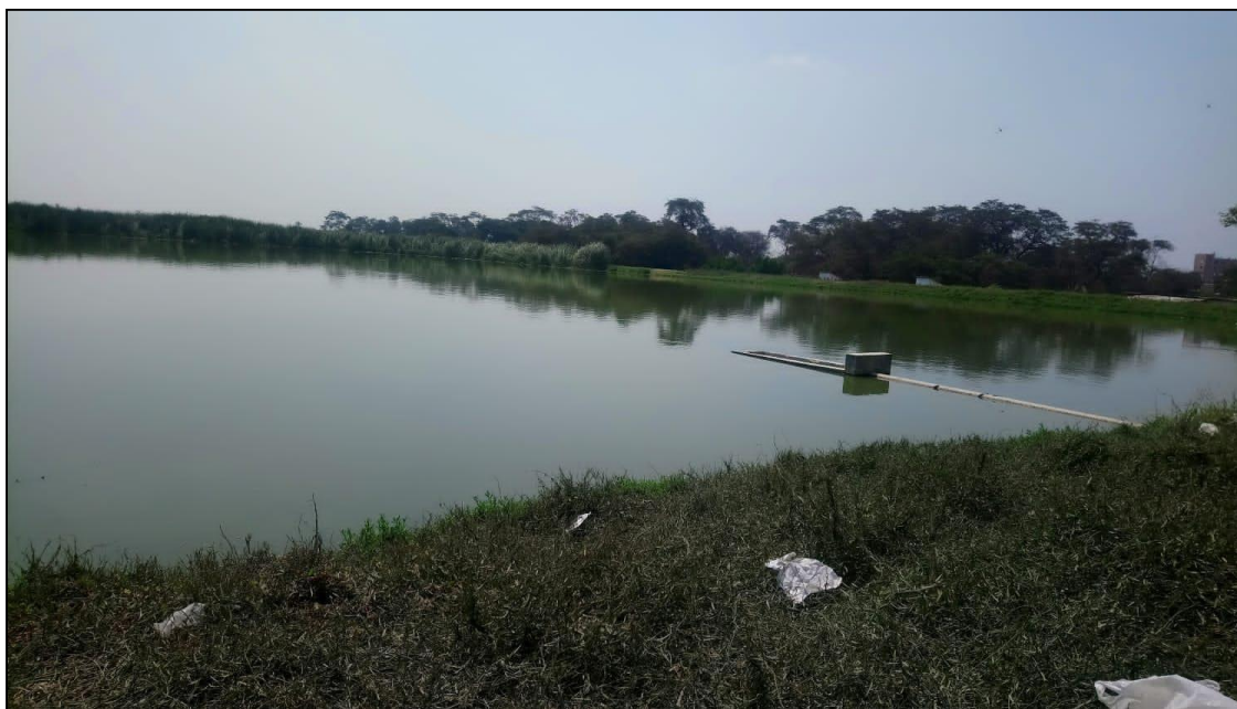
Ilustración 37 - PTAR de Jayanca, con un área aproximada de 3.5 ha
