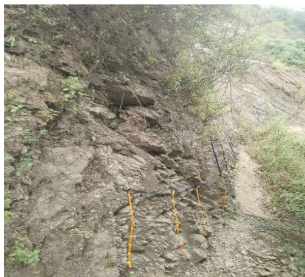
**Ilustración 66.** Meteorización del macizo rocoso grado III, Zona 4
