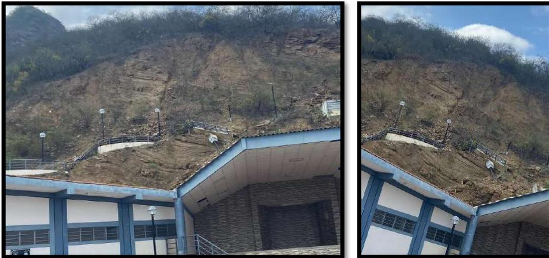
*Ilustración 1. Daños a estructuras públicas debido al desprendimientos del talud del cerro Chalpón*
