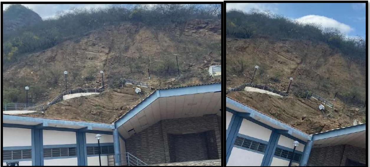
*Ilustración 129. Daños a estructuras públicas debido al desprendimiento del talud del cerro Chalpón.*
