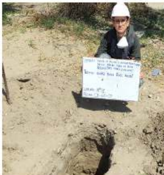
Anexo 17: Calicata N°1
