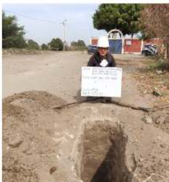
Anexo 19: Calicata N°3
