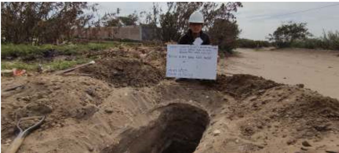
Anexo 7: Tercera calicata
