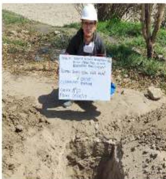
Anexo 18: Calicata N°2
