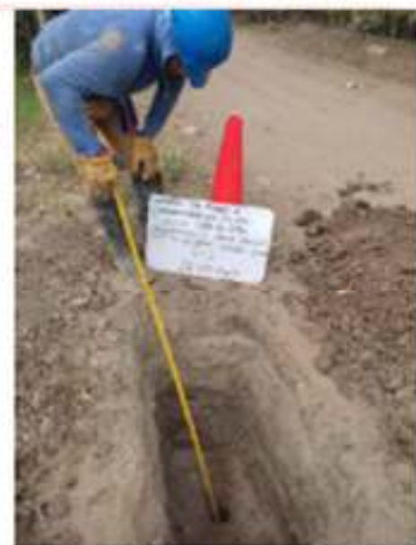
FOTO 04: VERIFICACIÓN DE PROFUNDIDAD ALCANZADA
