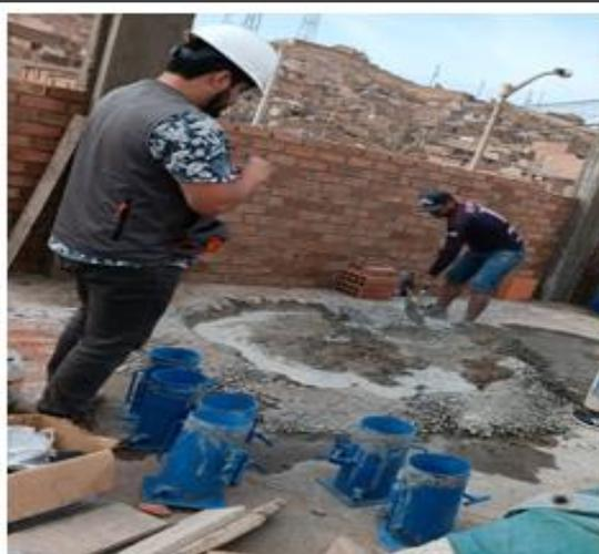
**Colocacion de petroleo al molde para facilitar desencofrado**
