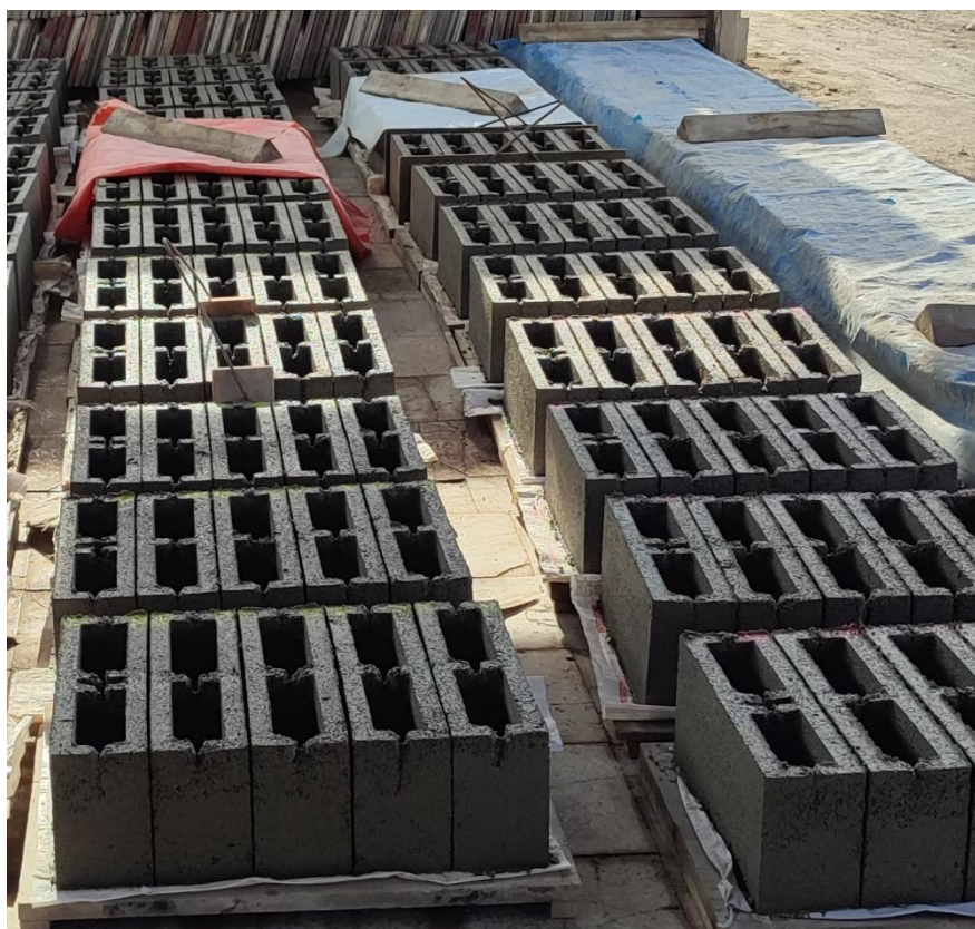
Fig. 44: Colocación de bloques de concreto para luego ser cubierto con plástico durante 24 horas
