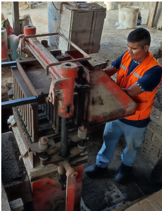
Fig. 40: Compactando y Vibrado de la mezcla de concreto para la elaboración de los bloques
