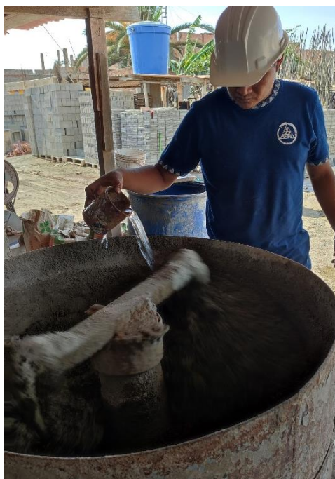
Fig. 37: Adicionamiento del agua de acuerdo al diseño de mezcla
