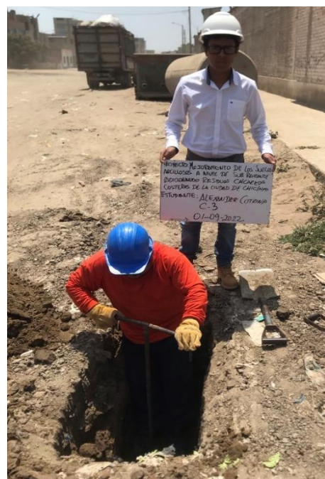
Figura 7: Calicata-03: Intersección Av. La Despensa y Dorado. Fuente: propia
