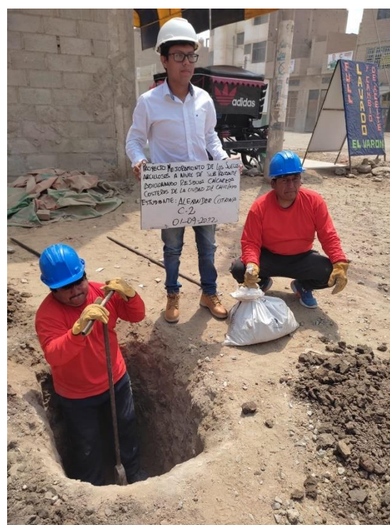
Ilustración N°2.5: Ejecución de Calicata 01. Fuente: Propia
