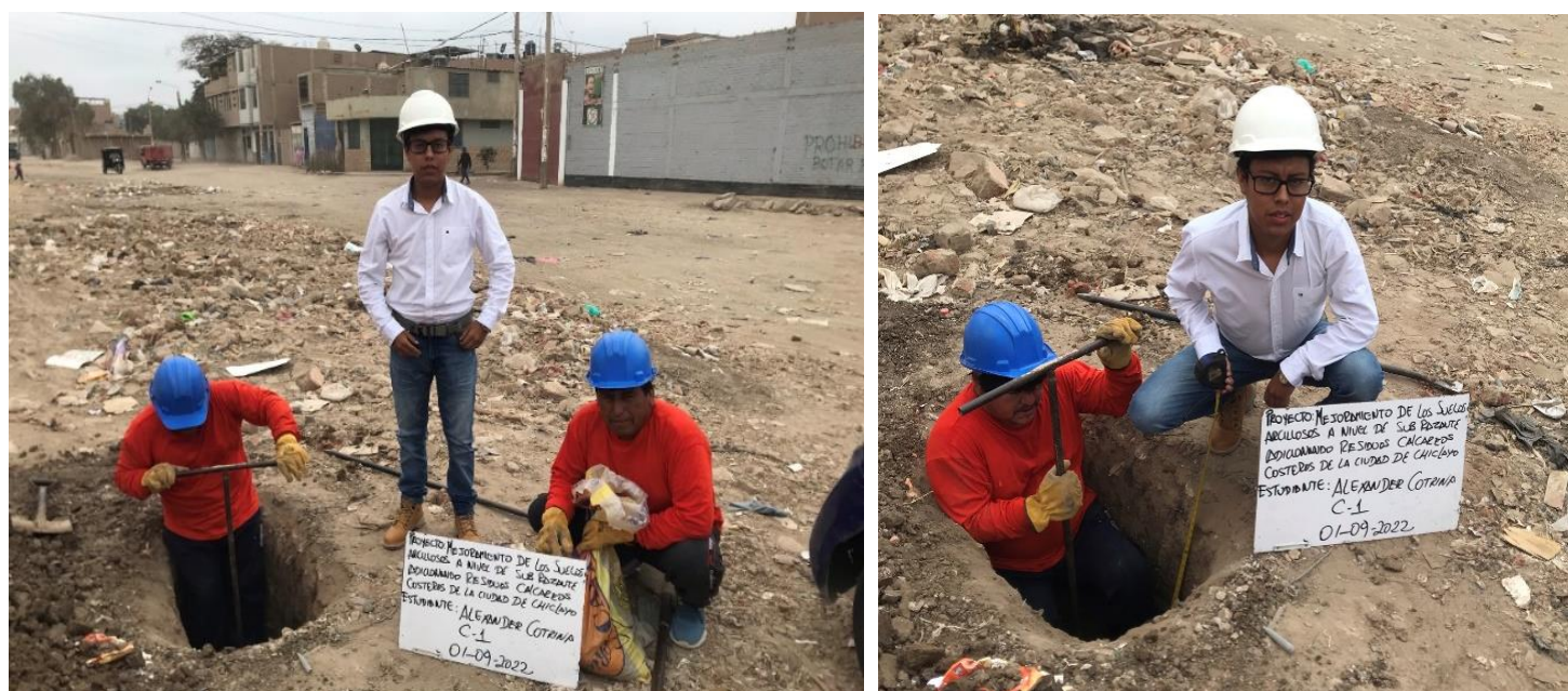
Figura 5: Calicata-01: Intersección Av. La Despensa y Antenor Orrego. Fuente: Propia
