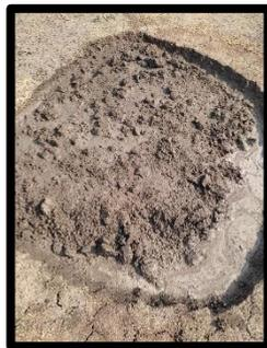
*Figura N° 47 Hidratación previa para unidades convencionales.*
