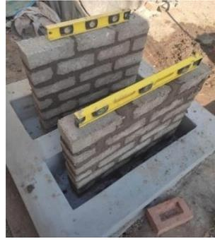
*Figura N° 102 Asentado de muros dentro de las pozas.*
