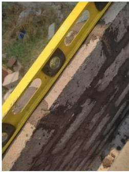
*Figura N° 103 Muro totalmente nivelado.*
