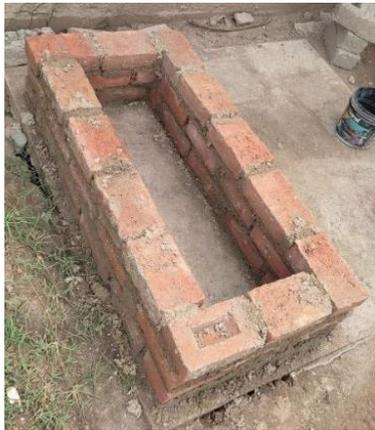
*Figura N° 99 Construcción de poza para el ensayo de Inundación Simulada.*
