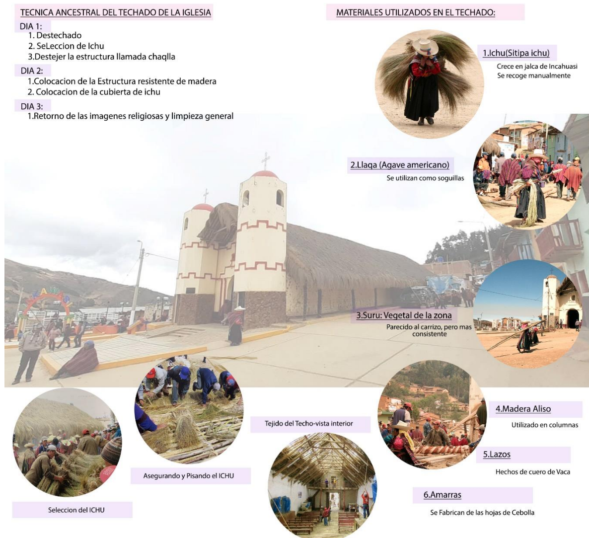
Ilustración 9. Techado de la Iglesia y Materiales Utilizados. Fuente: Propia- basado en la página web: Inkawasi Kañaros. https://inkawasi-kanaris.org/iglesia-qatay-el-techado-de-la-iglesia-de-incahuasi/
