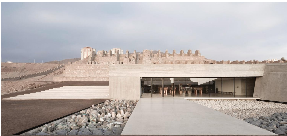
Imagen 13. Museo del desierto de Atacama. Monumento Ruinas de Huanchaca. Fuente ArchDaily
