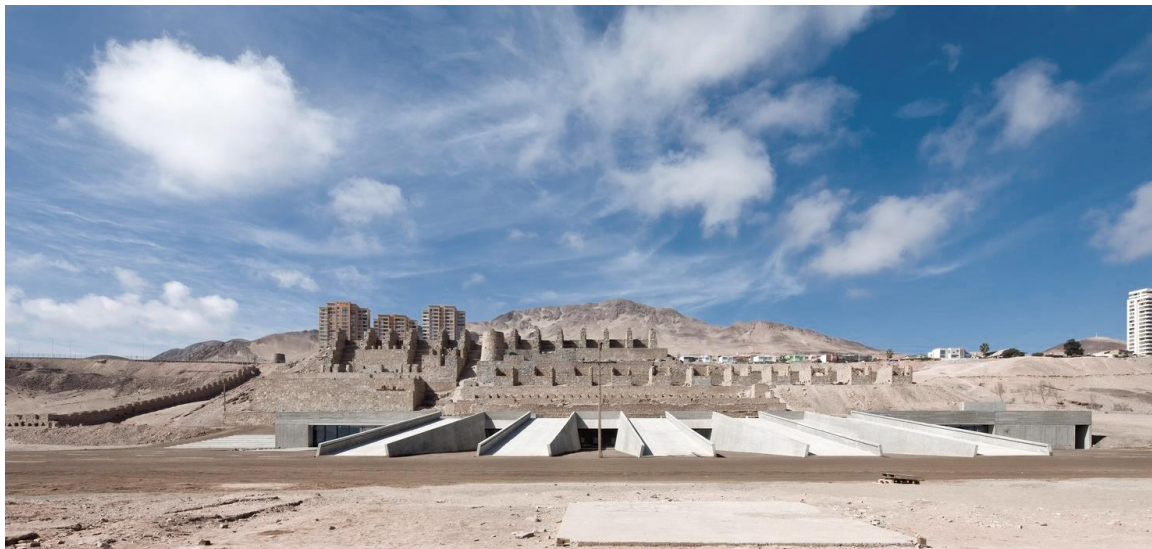
Imagen 12. Museo del desierto de Atacama. Monumento Ruinas de Huanchaca. Fuente ArchDaily
