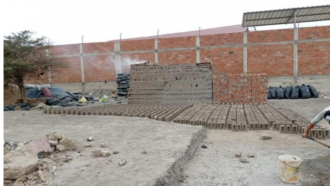
Ilustración 13: Vista de la Ladrillera
