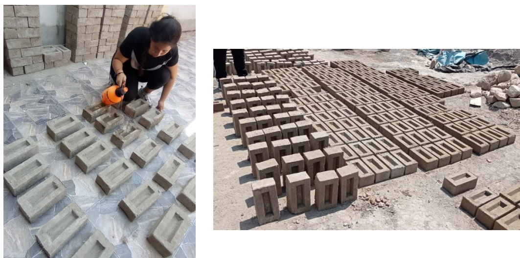
Ilustración 26: Secado y Curado de las Unidades Propuestas
