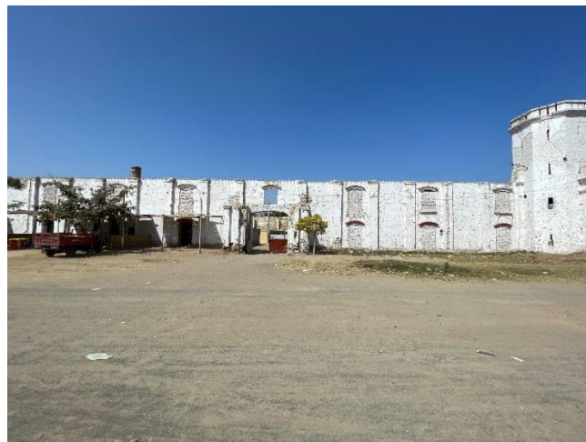
Figura 4 Vista noroeste del galpón
