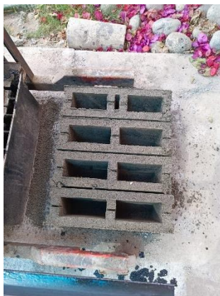
Figura N°31. Desmoldando los bloques de concreto
