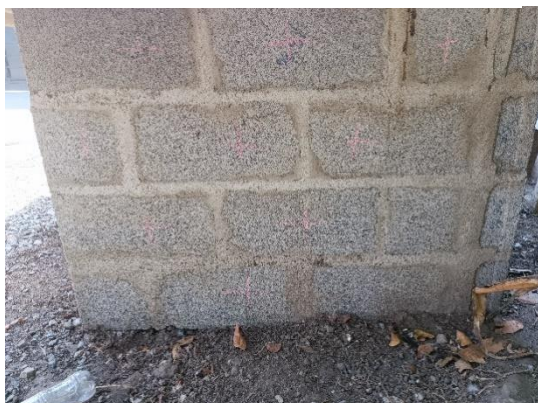
Figura N° 142 Marcación de los 9 puntos en 15% caucho
