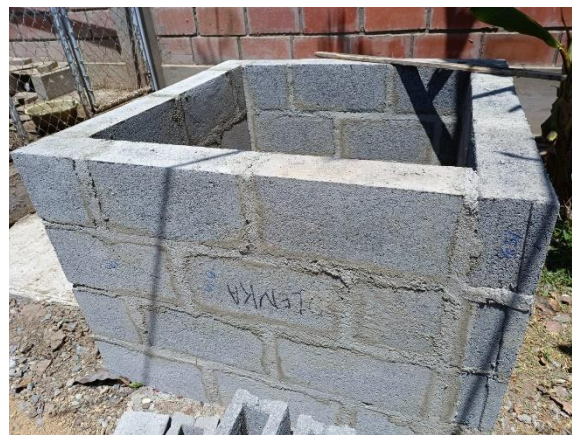
Figura N°80. Prototipo para el ensayo del aislamiento acústico
