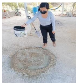
Figura N°26. Echando agua a la mezcla
