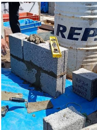
Figura N°63. Asentado de los bloques de concreto
