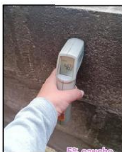
Figura N°121. Termómetro en la cara interna 5%
