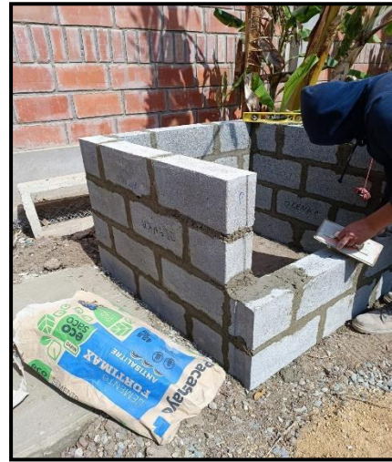
Figura N°77. Asentado de los ladrillos
