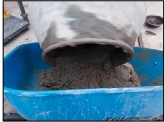
Anexo 2.2: Mezcla de concreto vaciada.
