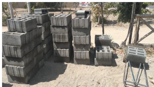
Figura N°33. Curado de los bloques de concreto
