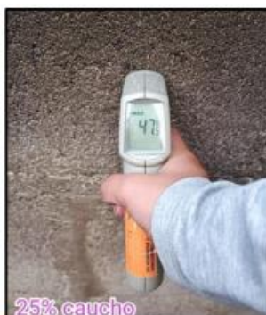
Figura N°123. Termómetro en la cara interna 25%
