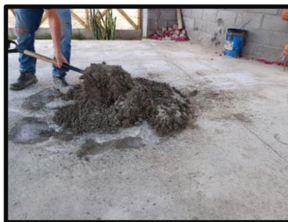
Figura N°27. Mezclando los materiales
