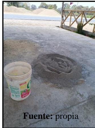
Figura N°25. Mezcla de los agregados
