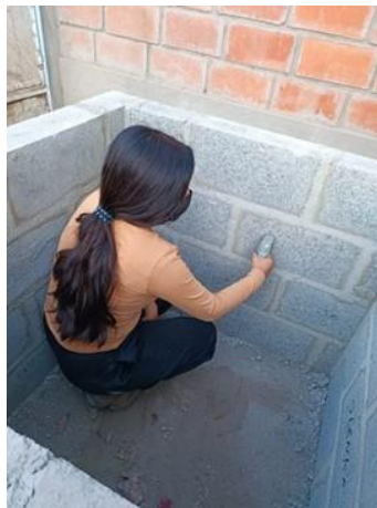
Figura N°96. Tomando medidas con el termómetro en las caras internas
