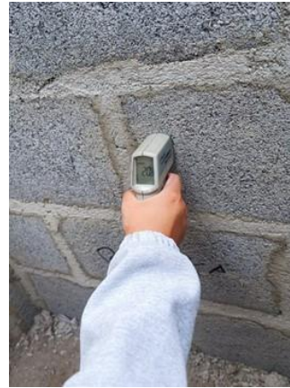
Figura N°109. Termómetro en la cara interna 15%
