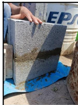
Figura N°66. Asentado de los bloques de concreto
