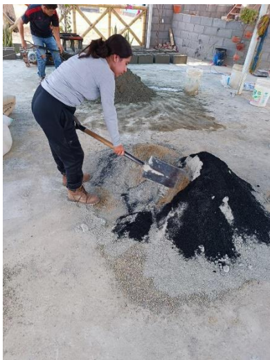
Anexo 5.1: Mezcla de los agregados y caucho reciclado. Fuente: Propia.
