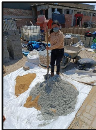
Figura N°65. Elaboración del mortero para primas
