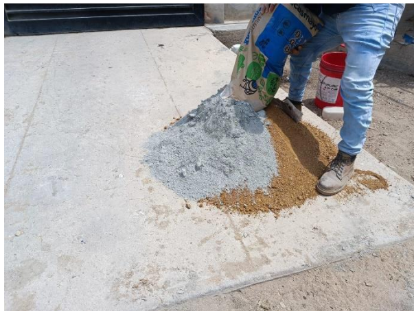
Figura N°75. Mezcla de los agregados
