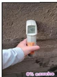
Figura N°120. Termómetro en la cara interna 0%
