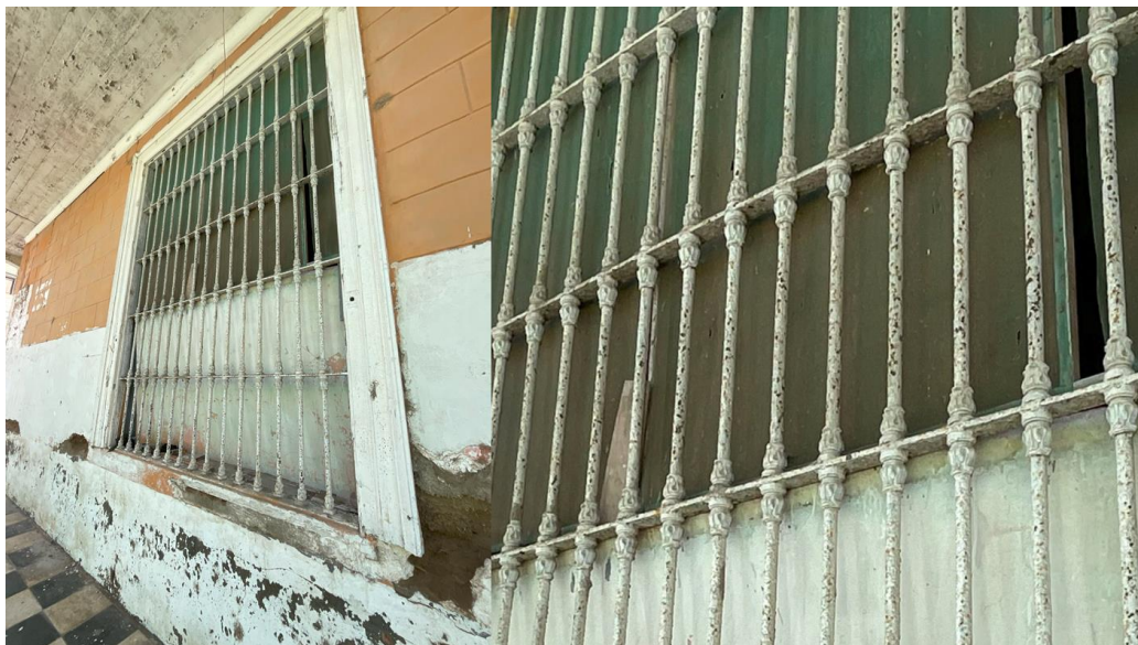
Figura 7: Protección de las ventanas
