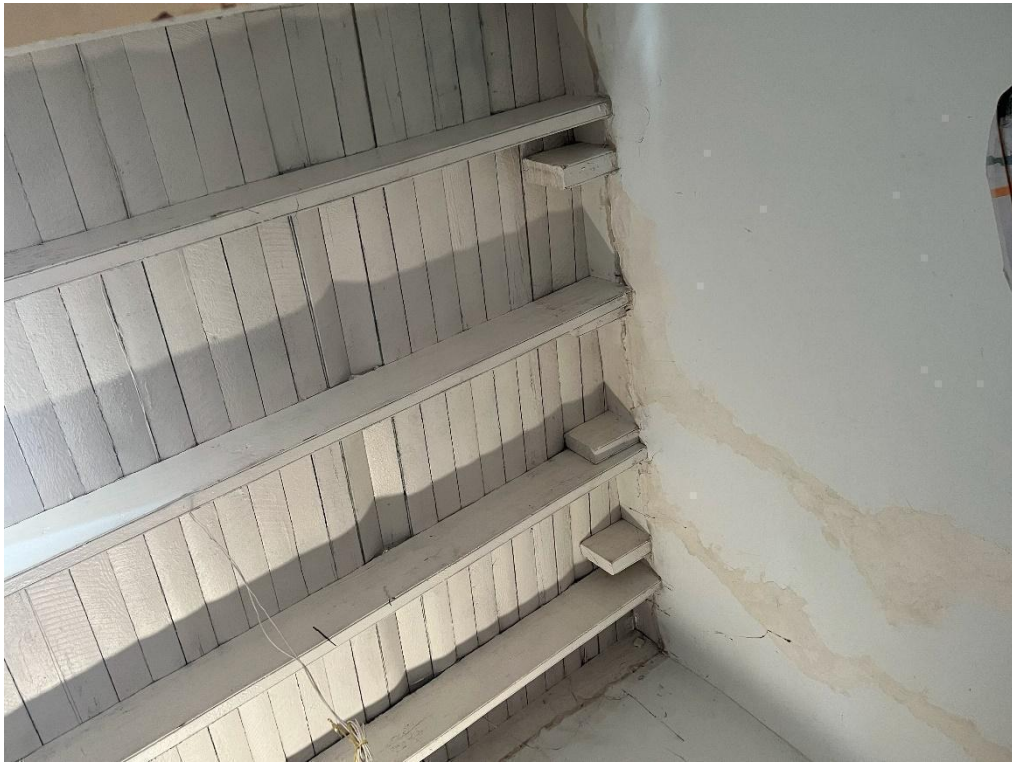
Anexo 17: Estado actual de la casona en la zona 4
