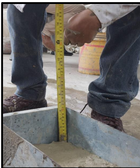
Ilustración 53: Toma de medidas - Caja de paso L
